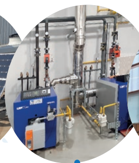
Deux chaudières gaz d'une puissance unitaire de 140 kW
